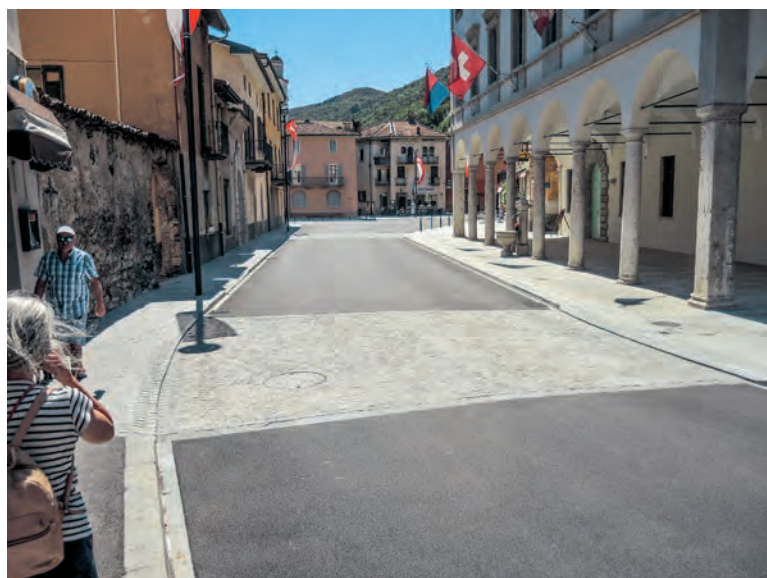
L'adozione di due diverse pavimentazioni induce il traffico motorizzato a moderare la velocità e a prestare maggiore attenzione.
