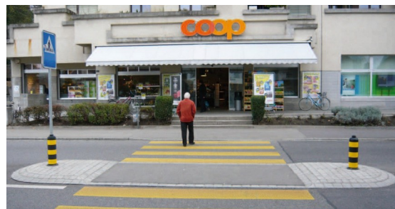
Bassersdorf ZH : le passage piéton avec îlot central se trouve sur la ligne de désir juste devant le magasin.
