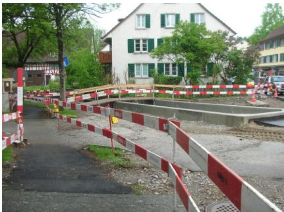
Exemplaire: grâce à la pose de revêtement et d'une passerelle piétonne, un cheminement temporaire adapté aux personnes handicapées a été réalisé.
