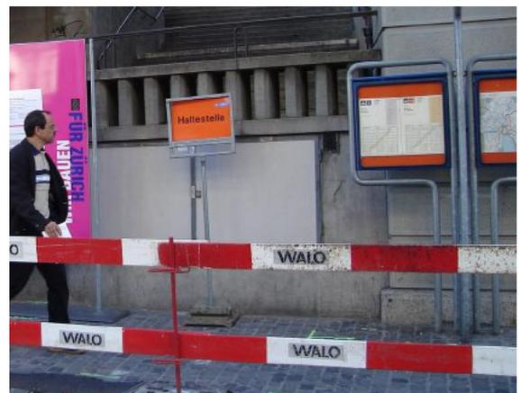
Améliorable: bien que l'arrêt soit supprimé à cause des travaux, il est indiqué par un panneau. Les installations et panneaux de chantier devraient être régulièrement contrôlés et adaptés.
