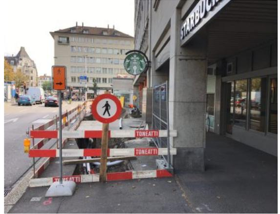
Exemplaire: liaison sécurisée passant derrière le chantier. La signalisation et l'indication du chemin sont correctes et compréhensibles.
