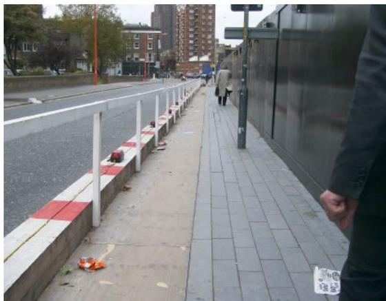
Exemplaire: le trottoir occupé par le chantier est élargi sans différence de niveau du côté de la chaussée. La délimitation tactile des deux côtés est également exemplaire.
