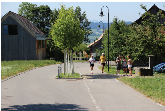
Route collectrice avec trottoir franchissable et rétrécissement ponctuel, Einengung, Meilen ZH
