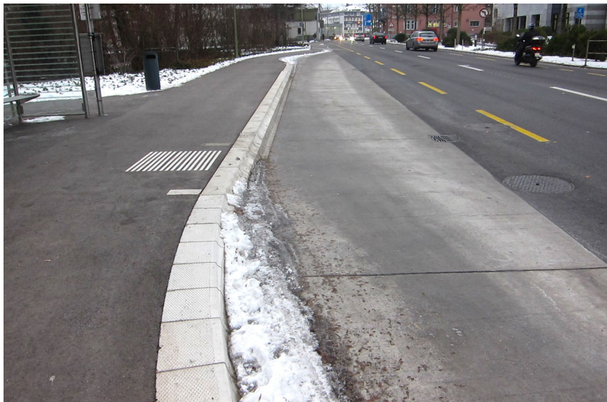
Fig. 27 – Liestal BL : malgré le renforcement du trottoir, qui raccourcit le tronçon d'accès, un arrêt de bus en encoche avec bordure d'accostage à niveau nécessite beaucoup d'espace (photo : Andreas Stäheli)
