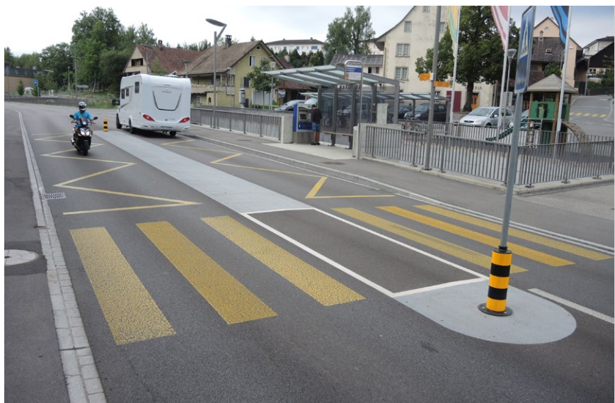
Fig. 24 – Niederlenz AG : l'îlot central permet aux piétons de traverser l'axe de transit en toute sécurité.
