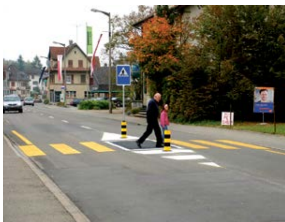
L'îlot est marqué au sol et signalé par des potelets.
