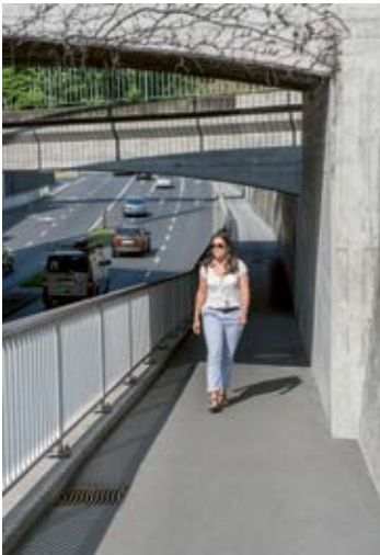
Espace piéton surélevé.
