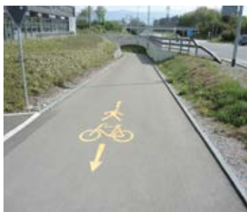
Peu avant un passage inférieur, les piétons et les vélos partagent le large trottoir.
