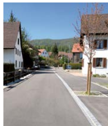
Trottoir d'un seul côté le long d'une rue de quartier.
