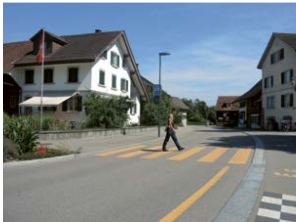
Passage piéton sans îlot central sur une rue peu fréquentée.
