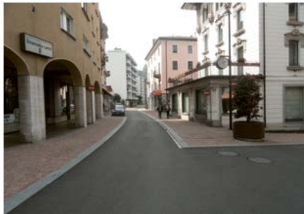
Grâce au redimensionnement du rayon de courbure, un espace de séjour a pu être créé.
