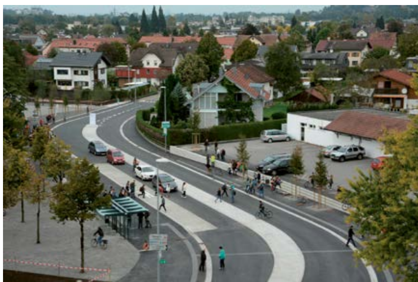
Bande polyvalente au milieu de la chaussée.
