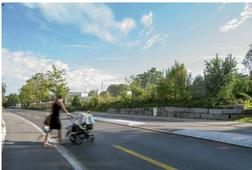
Traversée sans passage piéton avec îlot central.
