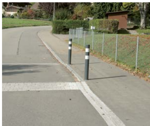
Traversée avec décrochement vertical ; les potelets empêchent les véhicules de rouler sur la zone d'attente.
