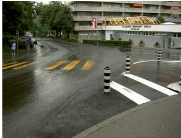
Situation peu claire, mauvaise visibilité, absence de délimitation entre le trottoir et la chaussée.
