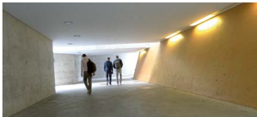
Passage inférieur aux dimensions généreuses, engageant et bien dégagé.
