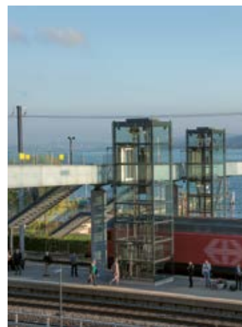
La passerelle dessert les quais grâce aux ascenseurs, relie entre eux plusieurs quartiers du village et facilite l'accès au lac.
