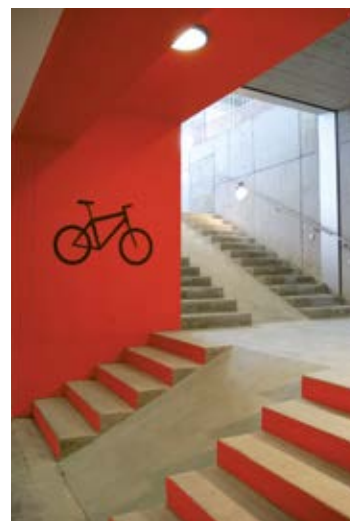
Accès à la vélostation adapté aux piétons et aux cyclistes.
