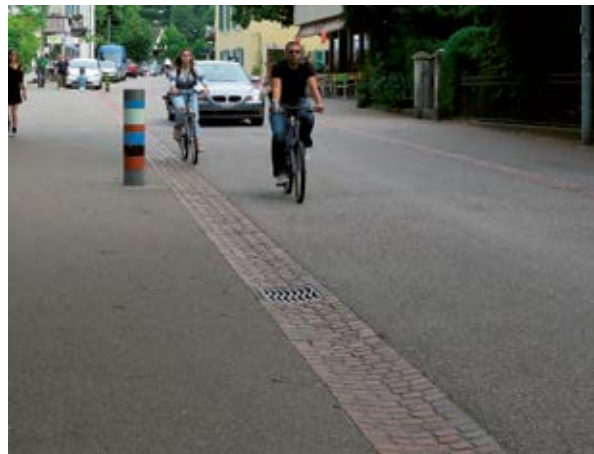
Séparation douce entre l'espace piéton et la chaussée avec une rigole d'écoulement, adaptée uniquement à des charges de trafic faibles
