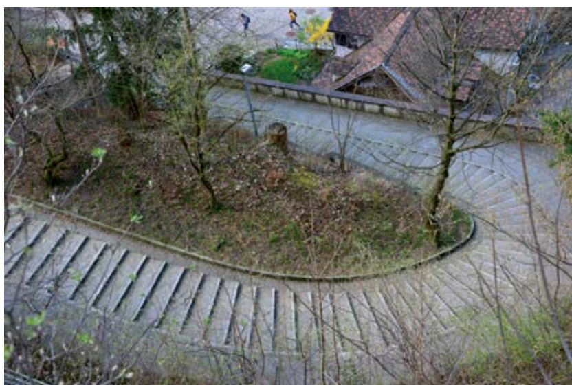
Escaliers et rampes combinés
