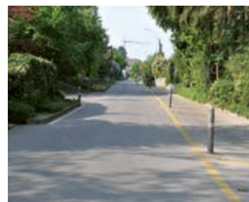
Bande longitudinale pour les piétons sécurisée à l'aide de potelets.
