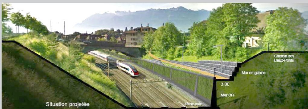
Figure 7 : Lausanne centre, situation projetée Tranchée du Languedoc : le cheminement de 3 m de large, autrefois inexistant, vient compléter le réseau piéton et vélo. Cet itinéraire dans un espace limité, a soulevé une réflexion quant à la cohabitation piéton/vélo à laquelle le GAP (Groupe accessibilité piétonne) a participé ([www.lausanne.ch/tranchee-languedoc](http://www.lausanne.ch/tranchee-languedoc)).
