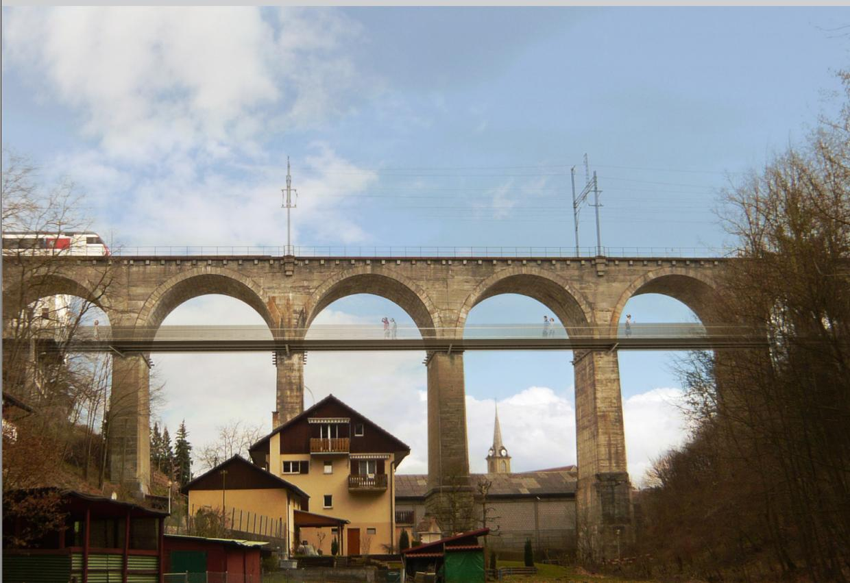
Figure 15 : Guin, le projet de la Transaggllo permet d'ajouter une passerelle mixte piéton/vélo sur le viaduc ferroviaire, afin de franchir le vallon Toggeliloch (photo © Nicolas Tapia, commune de Düdingen)
