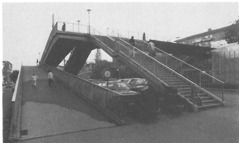
Fig. 7-2: Exemple de passage supérieur avec rampe séparée
