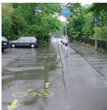
Zurich, Birchsteg : piste cyclable et chemin piéton avec partage de la surface de circulation. Le régime est mis en évidence par l'aménagement (différence de niveau), la signalisation et le marquage.
