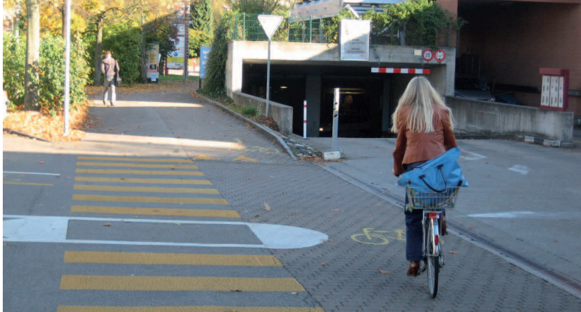
Une traversée sûre pour les piétons et pour les cyclistes est aménagée à la hauteur de l'entrée du parking souterrain (centre Ziegelei, Zollkofen, BE).
