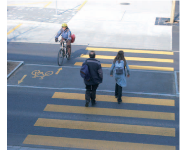
Les cyclistes traversent en suivant un marquage parallèle au passage pour piétons, ce qui réduit les risques de conflits avec ceux-ci (Affoltern a.A., ZH).
