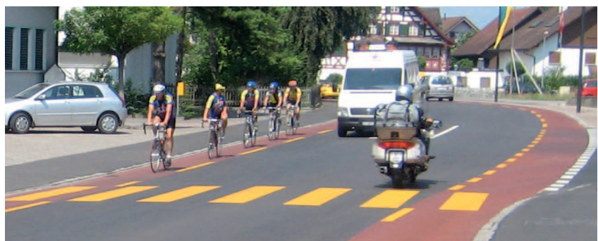
Pour une meilleure protection des cyclistes, un dispositif avec chaussée à voie centrale banalisée a été mis en place (Oberriet, SG).
