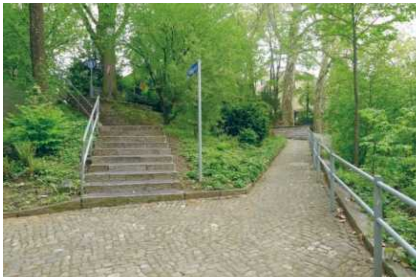
Les points de départ et d'arrivée des escaliers et des rampes doivent être aussi proches que possible.
