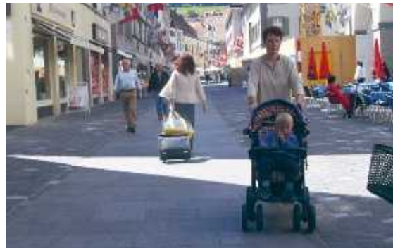
Le revêtement en dalle au centre de cette ruelle pavée en vieille ville réduit la résistance au roulement. Elle n'est pas seulement appréciée des personnes en chaise roulante, mais aussi de celles qui poussent un landau ou tirent une valise.
