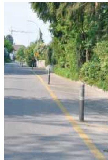
Bande longitudinale sécurisée à l'aide d'un poteau.
