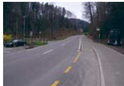
Il manque un aménagement de la traversée.
