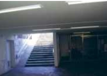
Mauvais exemple : passage inférieur avec des recoins non visibles.
