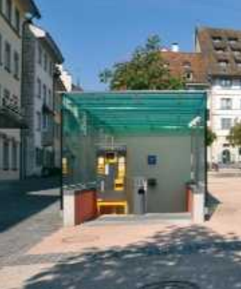
Accès attractif et sûr à un parking.
