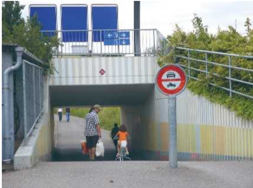
Bonne visibilité d'une extrémité à l'autre du passage inférieur, en ligne droite.
